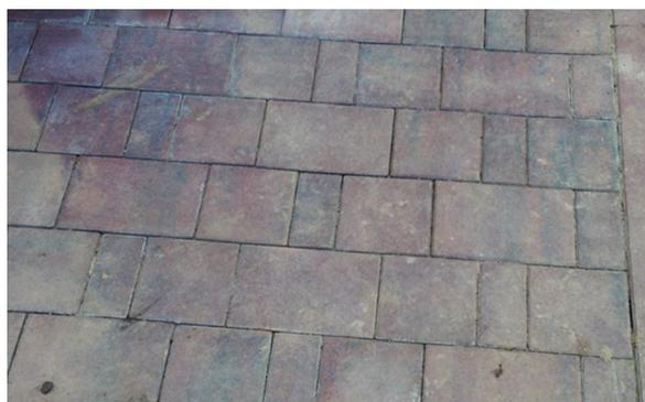
**Рисунок 28.** Покрытие с высолами на пескоцементном подстилающем слое.
